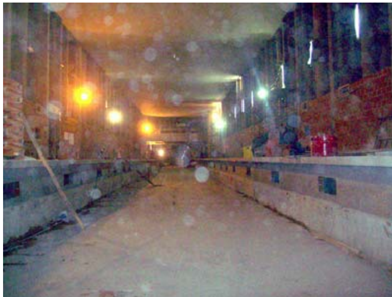
Foto N° 2. Estación Parque Patricios. Vista de andenes y muros de mampostería entre pilotes.
