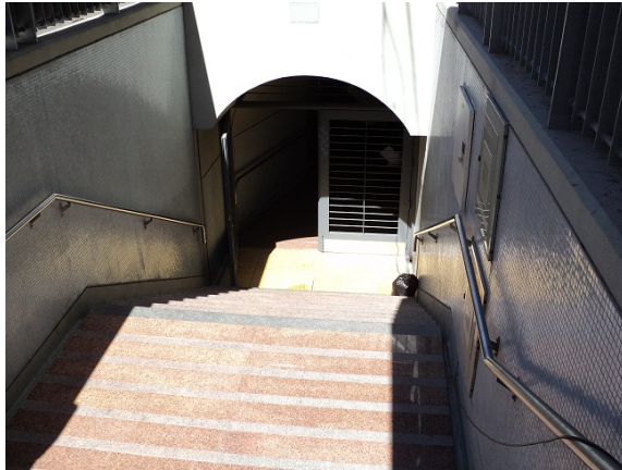
Foto N° 9. Escalera de ingreso Av. Corrientes.
