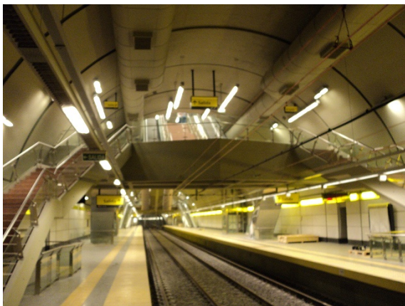
Foto N° 13. Vista de Andenes y Entrepiso.
