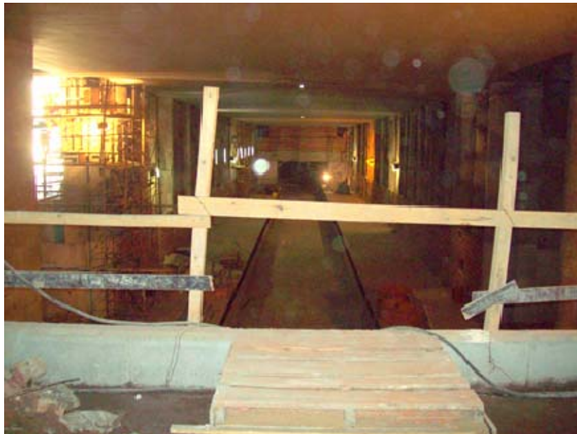
Foto N° 4. Estación Parque Patricios. Vista de los andenes desde el vestíbulo del entrepiso.
