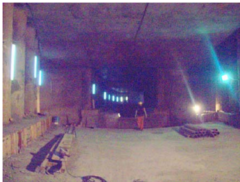
Foto N° 6. Túnel. Muñón Almafuerde en Progresiva N° 2008.
