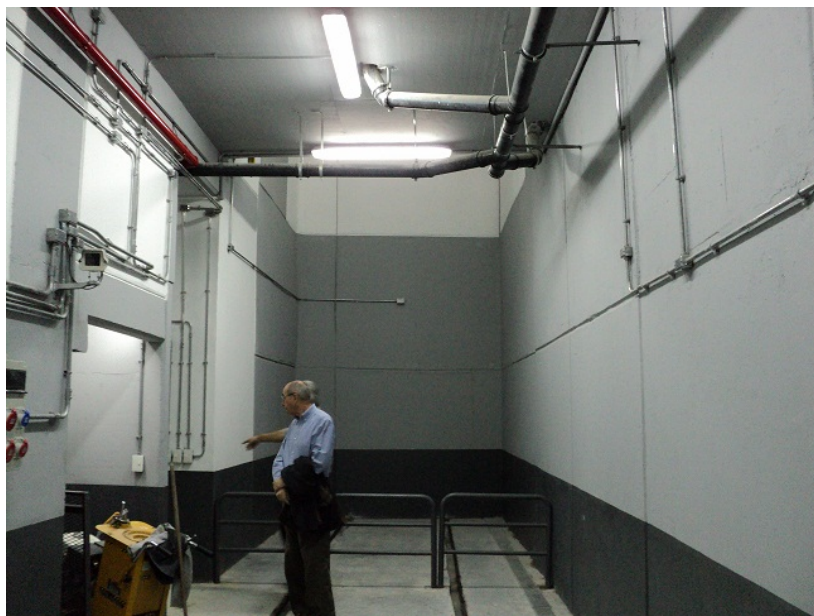
Fotos N° 23. Acceso del Puente Grúa al segundo subsuelo desde donde se trasladan los Boggies mediante un camino de sodaduras hasta el taller Colonia.
