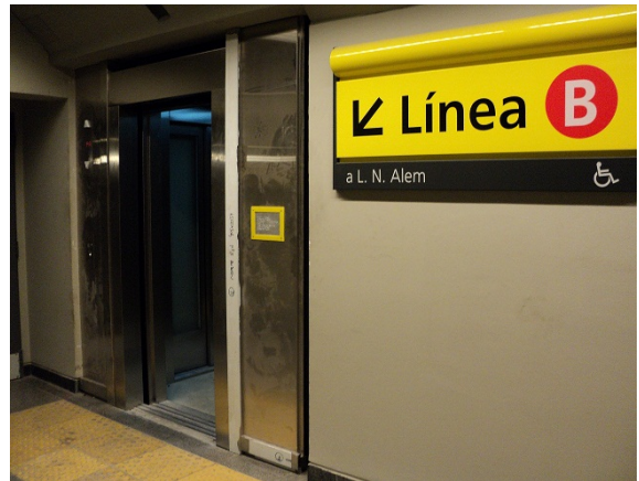
Foto N° 16. Ascensor en nivel andén que permite conexión con Línea B.
