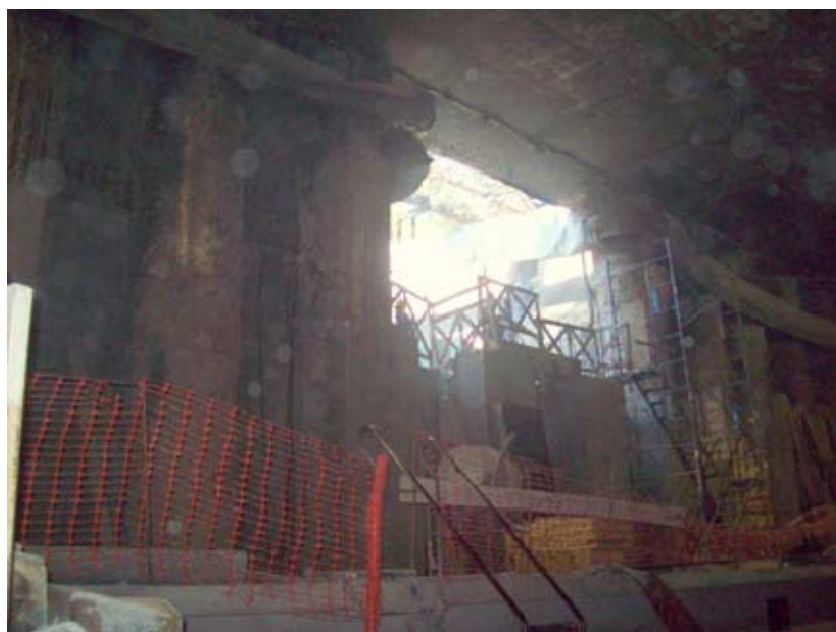
Foto N° 8. Estación Hospitales. Vista de andén, pilotes, columnas de apoyo de losa de entrepiso y abertura antigua rampa Av. Almagro.
