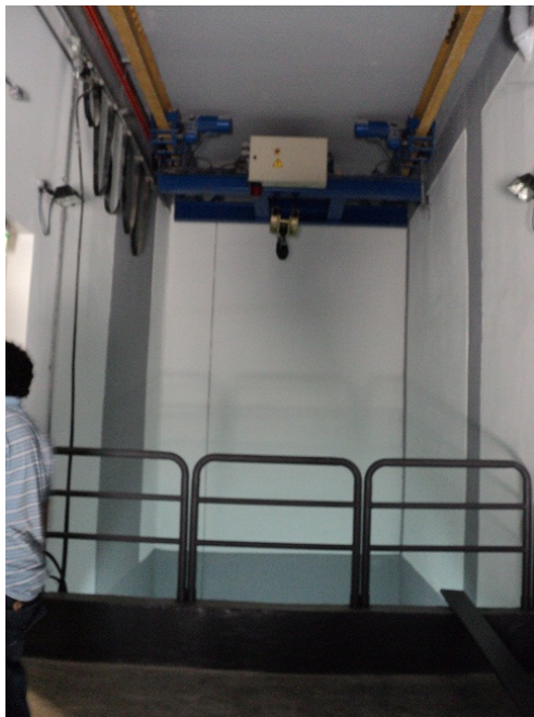
Fotos N° 21 y 22. Puente Grúa instalado en la losa del Edificio Auxilia al Taller Colonia.
