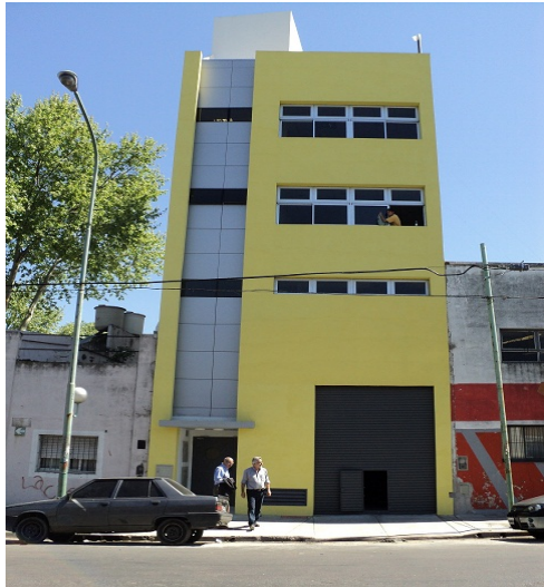
Fotos N° 19 y 20. Vista frontal y lateral de la fachada del Edificio Auxiliar al Taller Colonia.
