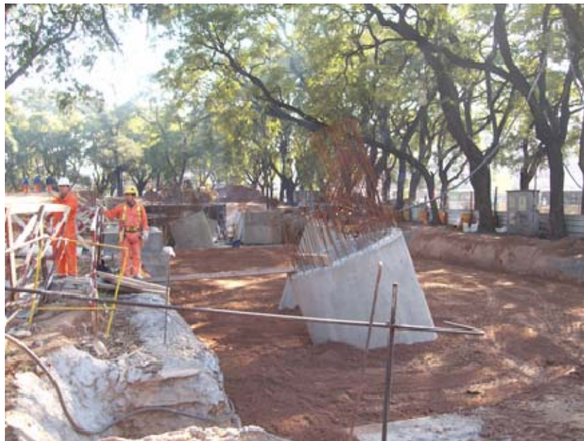
Foto N° 5. Estación Parque Patricios. Lucarnas de Hormigón para iluminación cenital de acceso a estación.
