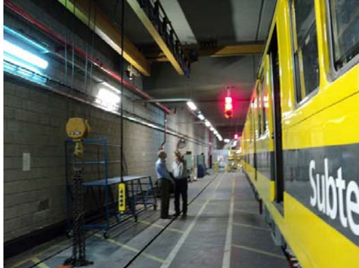
Foro N°28. Vista del Taller Colonia donde está Emplazado el Puente Grúa Construido por Siemens SA
