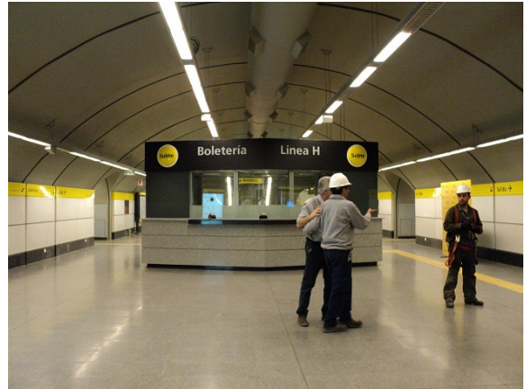
Foto N° 10. Vestíbulo y Boletería.
