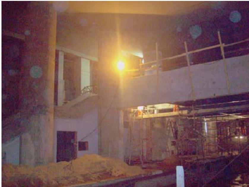
Foto N° 3. Estación Parque Patricios. Vista de andén, circulación vertical y vestíbulo del entrepiso.
