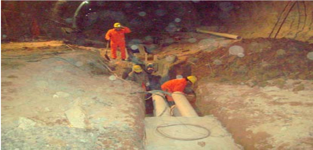
Foto N° 1. Túnel. Ejecución de pozo de bombeo para drenaje en progresiva N° 2360/2370 concordante con rampa de acceso calle Pepirí.
